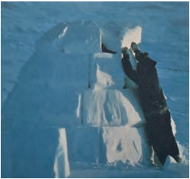
9 Rakenteilla oleva igloo.
